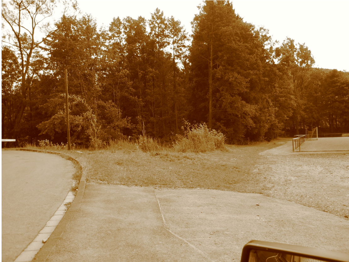
Abb. 12 Parkplatz vor der Sanierung 36
