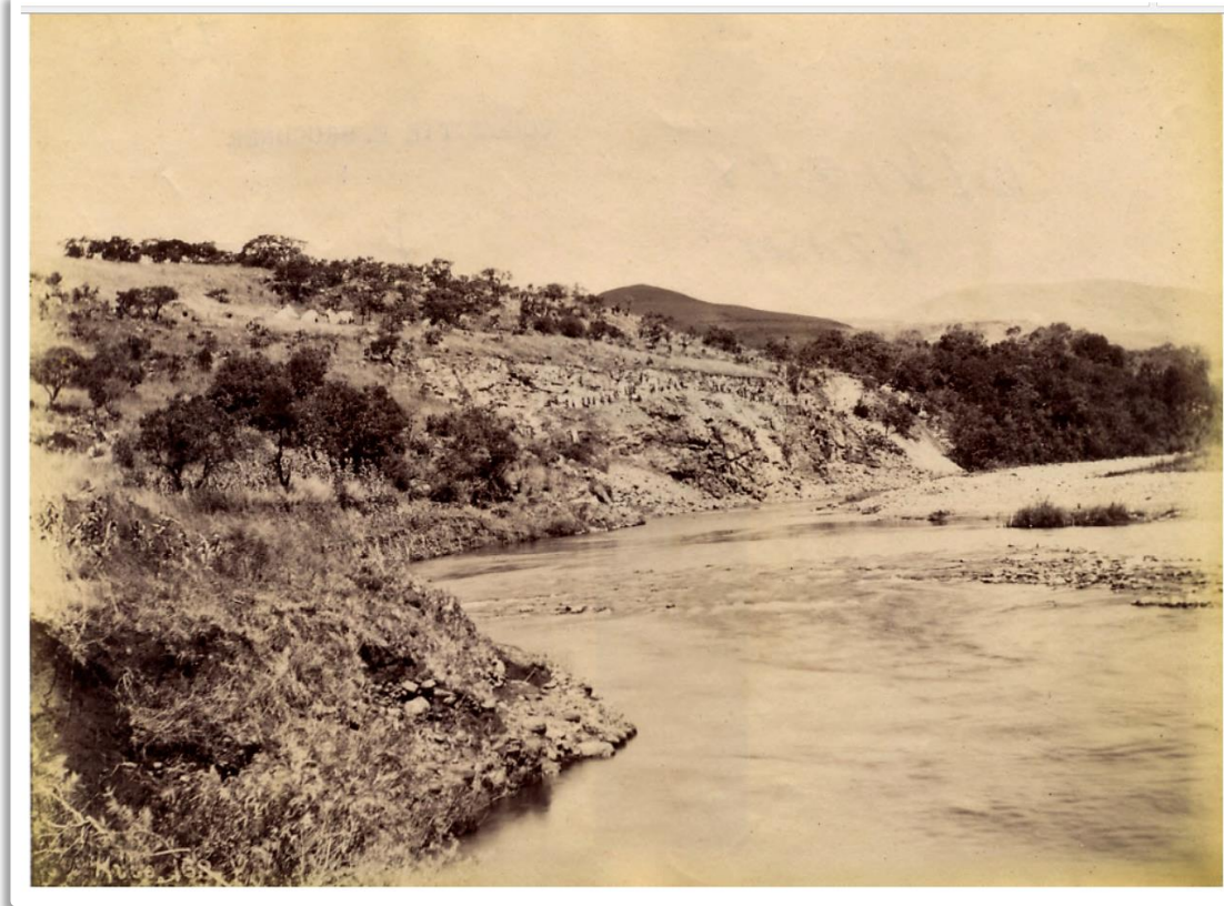
Figure 42 View of the construction towards the Ngodwana Bridge KM 168, 1892. Photo: Het Zuid-Afrikahuis Map74-15 1348.
