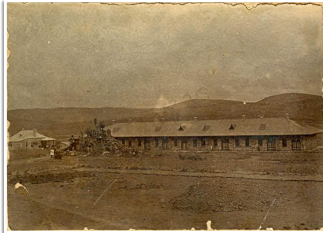
Figure 90 Administrative buildings under construction in Waterval-Boven, Oosterlijn. Photo: Het Zuid-Afrikahuis Map169-21 3551.
