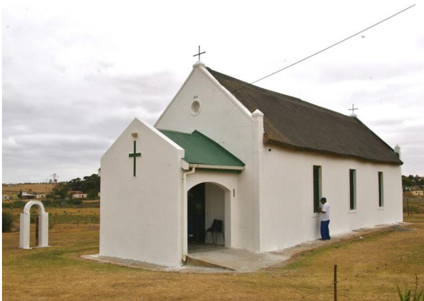
Foto 16: Inwoners besig met instandhoudingswerk aan die Congregational Church op Slangrivier 533
