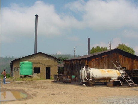
a) Creosote storage tank
