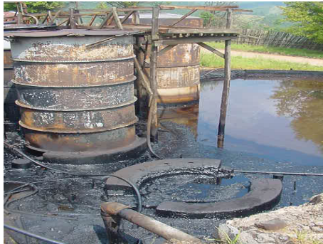
f) Effluent ponds
