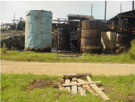
e) Effluent ponds and trench
